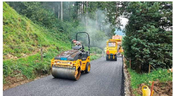
Bei der Schlattstrasse wird der Deckbelag eingebaut.
