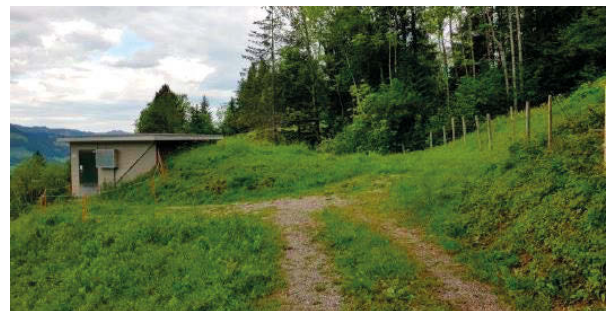
Zufahrt zum heutigen Reservoir Hinterberg
