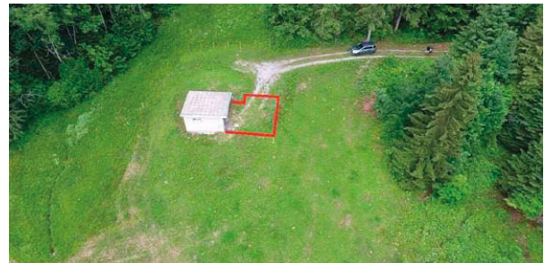
Situation mit Anbau
