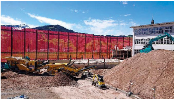
Das Areal alte Weberei im Bauschutt
