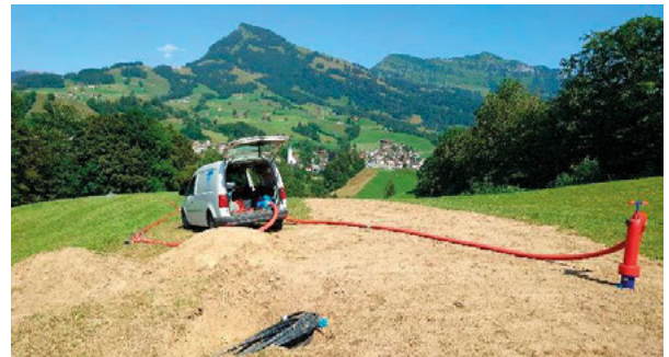
In der Bürzlen wird der Hydrant angezapft.
