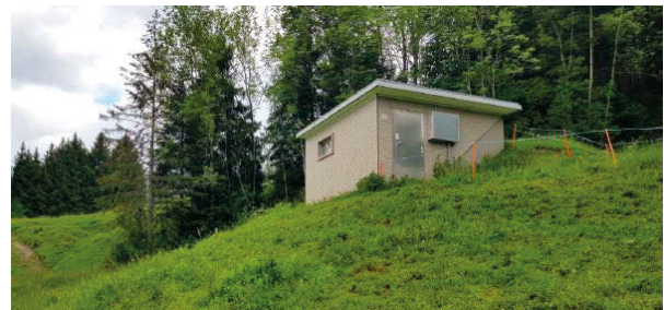
Sicht auf das Rohrkellergesamtheit
