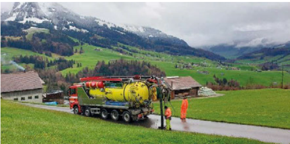
An der Gublenstrasse wird die Meteorleitung gespült.
