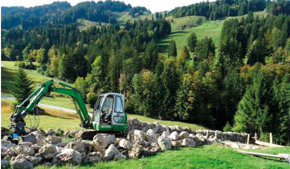
Sanierung Trockenmauer
