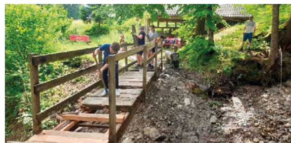
Schwefelquelle Rietbad: Ersatz Holzsteg
