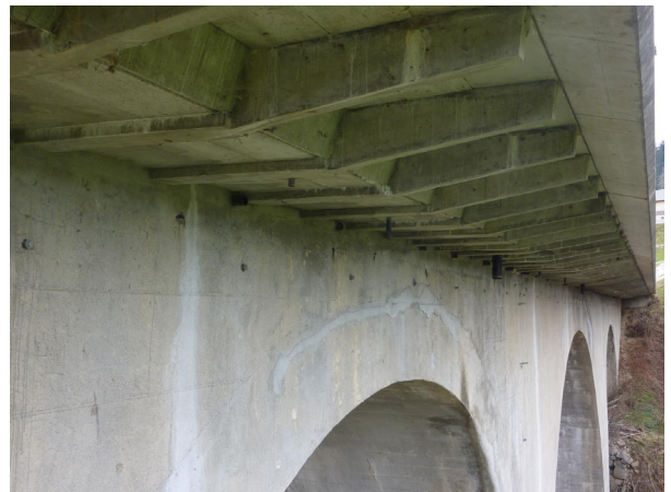
Fahrbahnerweiterung über vorfabrizierten Trägern
