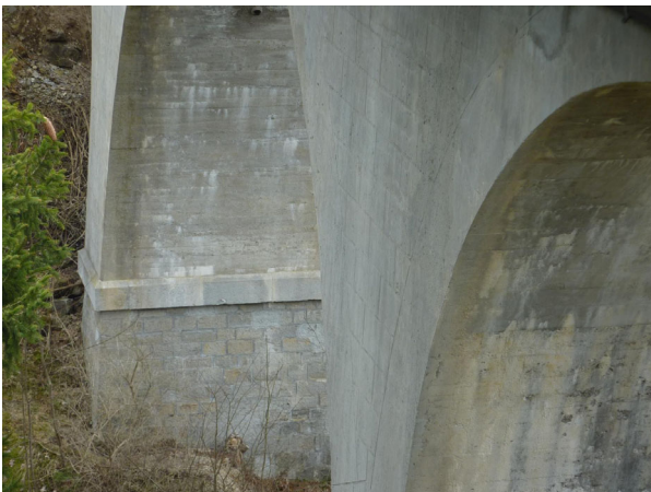
Details Rundbogen mit Grundpfeiler in Natursteinmauerwerk
