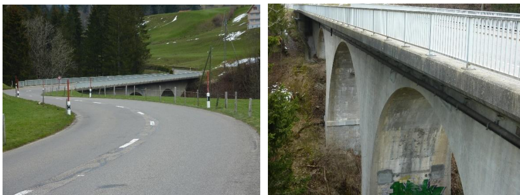
Lutererbrücke, Ennetbühl, April 2021 (Fotos: ERR Raumplaner AG)
